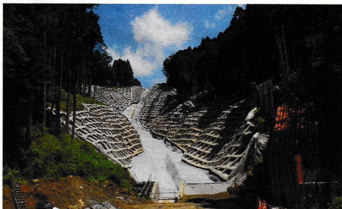
崩壊区域完了 (R3.6.10撮影)
