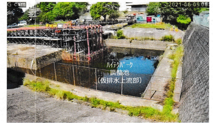
仮排水上流部 (ポンプ10台)
